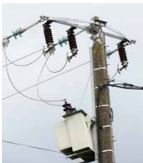
Figure 4 : poste de distribution publique aérien. Réseau HTA à gauche, transformateur HTA/BT sur poteau, réseau torsadé BT à droite
